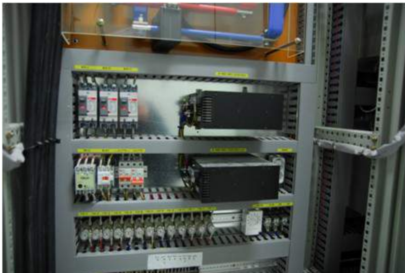
그림 3-4 MCCB Panel DC Power Supply
