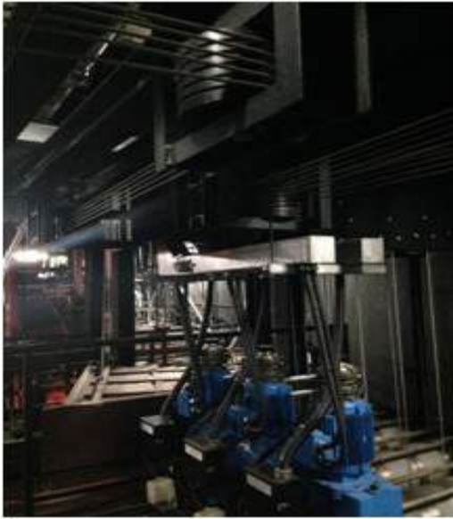
그림 1-2 Apron grid 구동부 수평 활차
