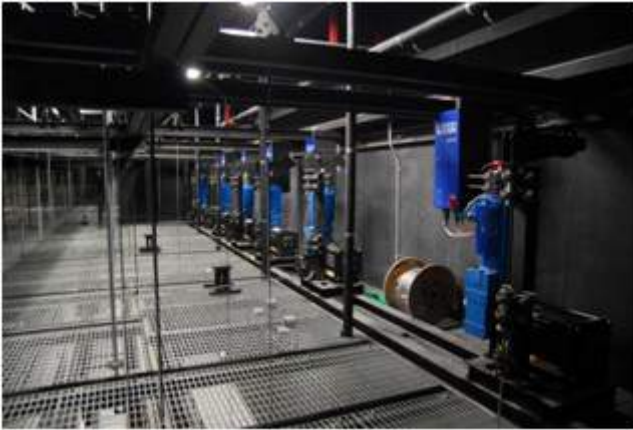
그림 2-21 One Point Winch 방식
