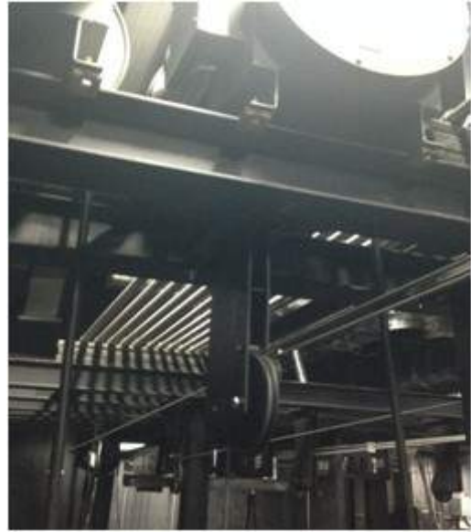
그림 1-3 Apron grid 구동부 수직 활차
