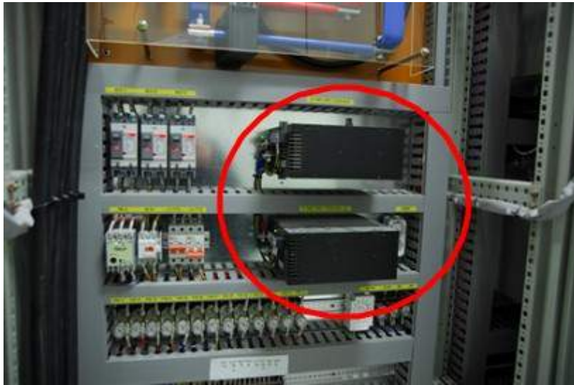
그림 3-6 Power Supply 병렬 설치
